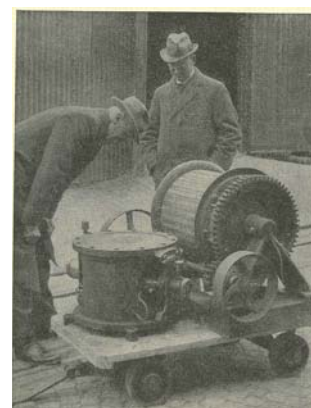
Wenströms dynamomaskin till vänster och elektromagnetiska malmseparator till höger
